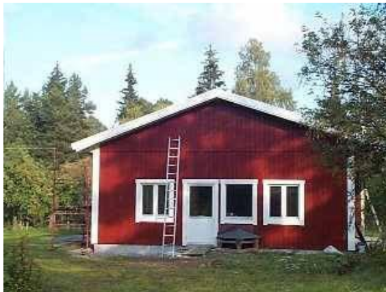
Fasad från väster under tillbyggnad 2000.
